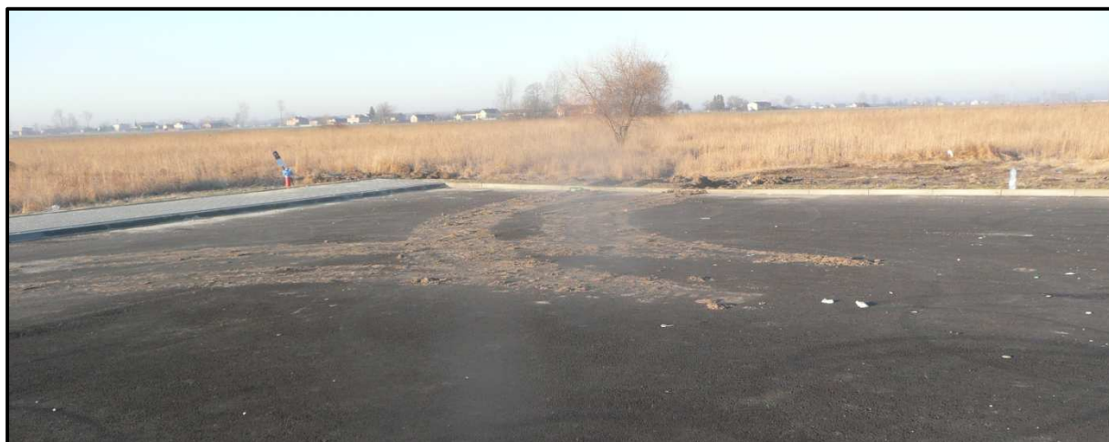
Fot. 1 – widok działki inwestycyjnej od strony wsch. - z utworzonej drogi dojazdowej
